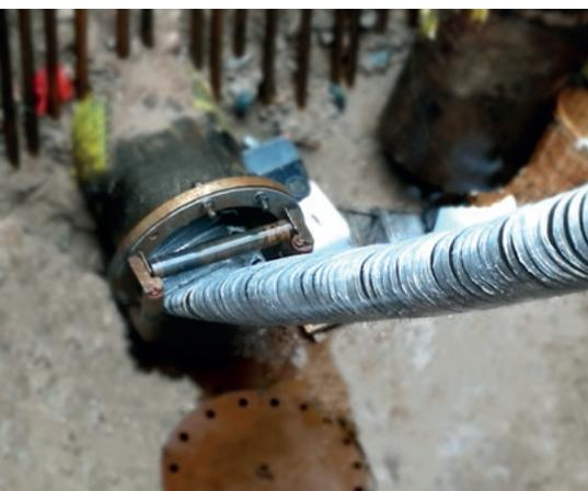
Der IH LINER ist die optimale Lösung für die grabenlose Sanierung von Druckleitungen
