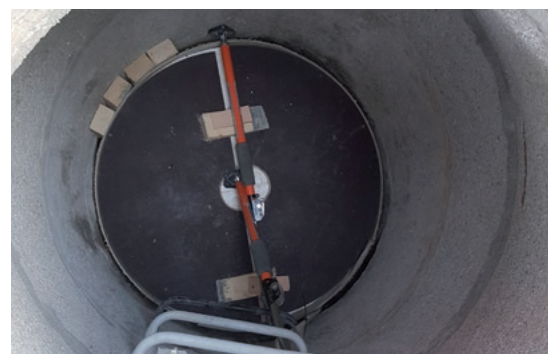
Der FLEXLINER® wird mit einem Spezialmörtel hinterfüllt
