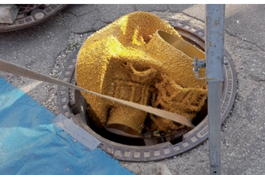
Der FLEXLINER® kann verformt werden und besteht aus chemikalienbeständigem Polyurea
