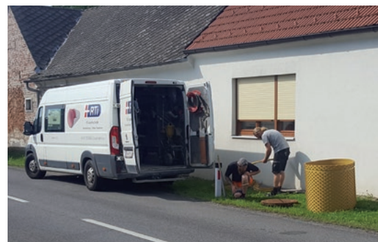
Der FLEXLINER® ermöglicht eine absolut rasche und grabungsfreie Sanierung des Abschlachtes
