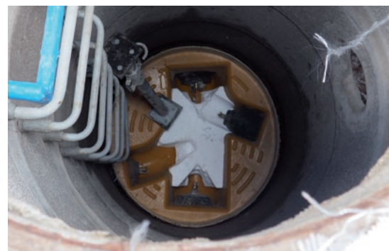
Das Styropormodell dient als Stützkern während der Sanierung
