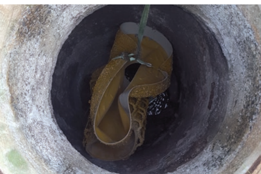
Zerstörungsfreies Einbringen des FLEXLINERS® durch den Schachteinstieg
