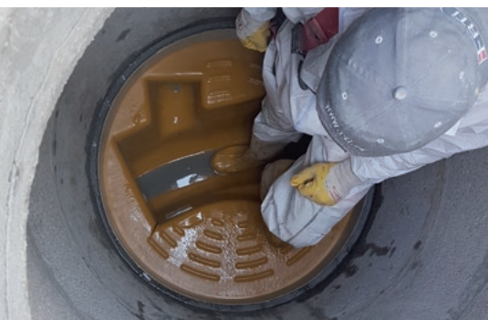
Der FLEXLINER® wird im Schacht zur ursprünglichen Form entfaltet
