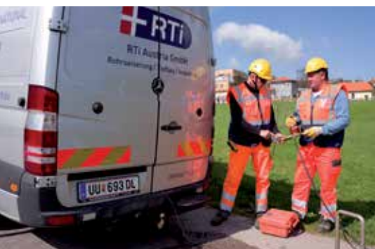
Druckprüfung einer Freispiegelleitung
