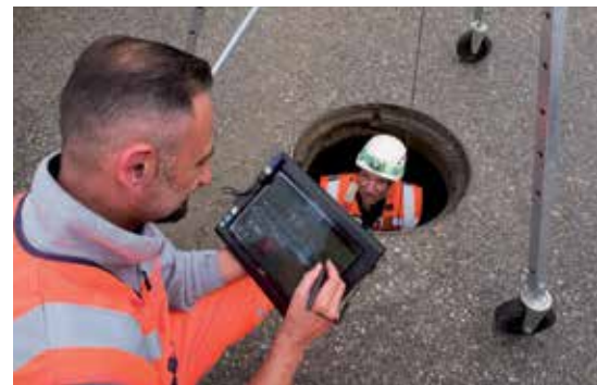
Wartungsarbeiten für Schachtbauwerke
