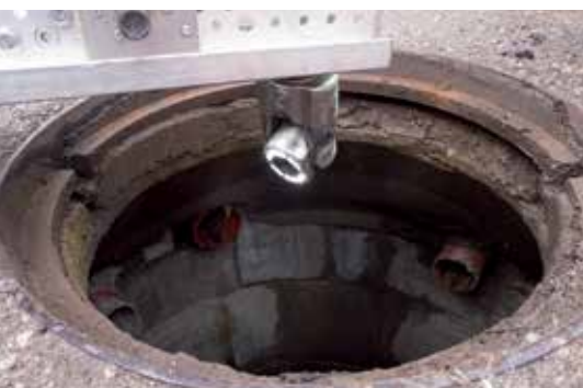
Schachtinspektion mittels Schachtkamera
