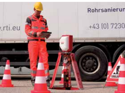
Schachtinspektion mittels Scan-Technologie
